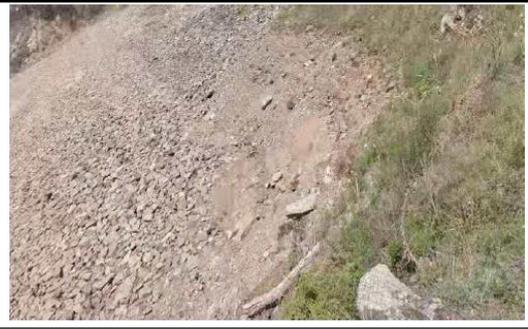
大坝上游护坡及近坝岸坡表层风化，局部砌石缺失
