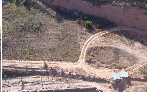
照片 1.3-2 已有矿山道路
