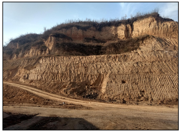
照片 1.3-2 已有矿山道路
