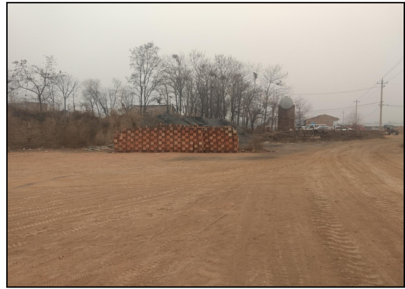
照片 1.3-2 已有矿山道路
